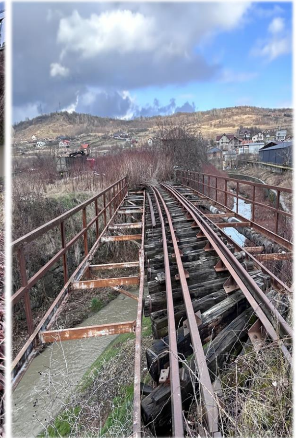
Trecere de Cale ferată corodată de-a lungul timpului
