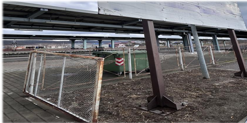
29.8 micrometri vopsea/rugină și daune mecanice cauzate de coroziune
