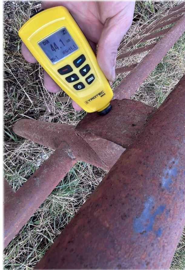
Balustradă de pe malul Văii Zalăului.
