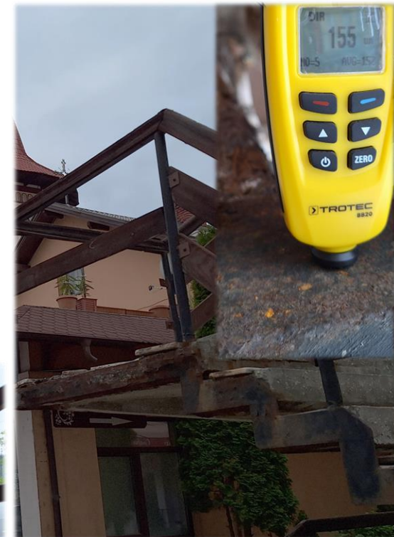
Scări afectate de coroziune, întreaga scară a clădirii este ruginită masurând peste 155 microni de rugină.
