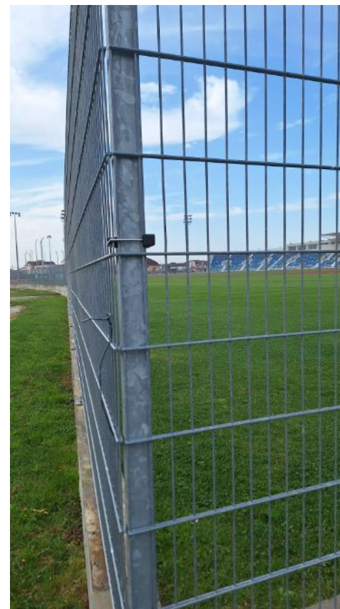
Elementele zincate termic nu sunt afectate de coroziune. Grosimea de strat de 25 de microni asigură o protecție anticorozivă de minim 12 ani fără cheltuieli de întreținere
