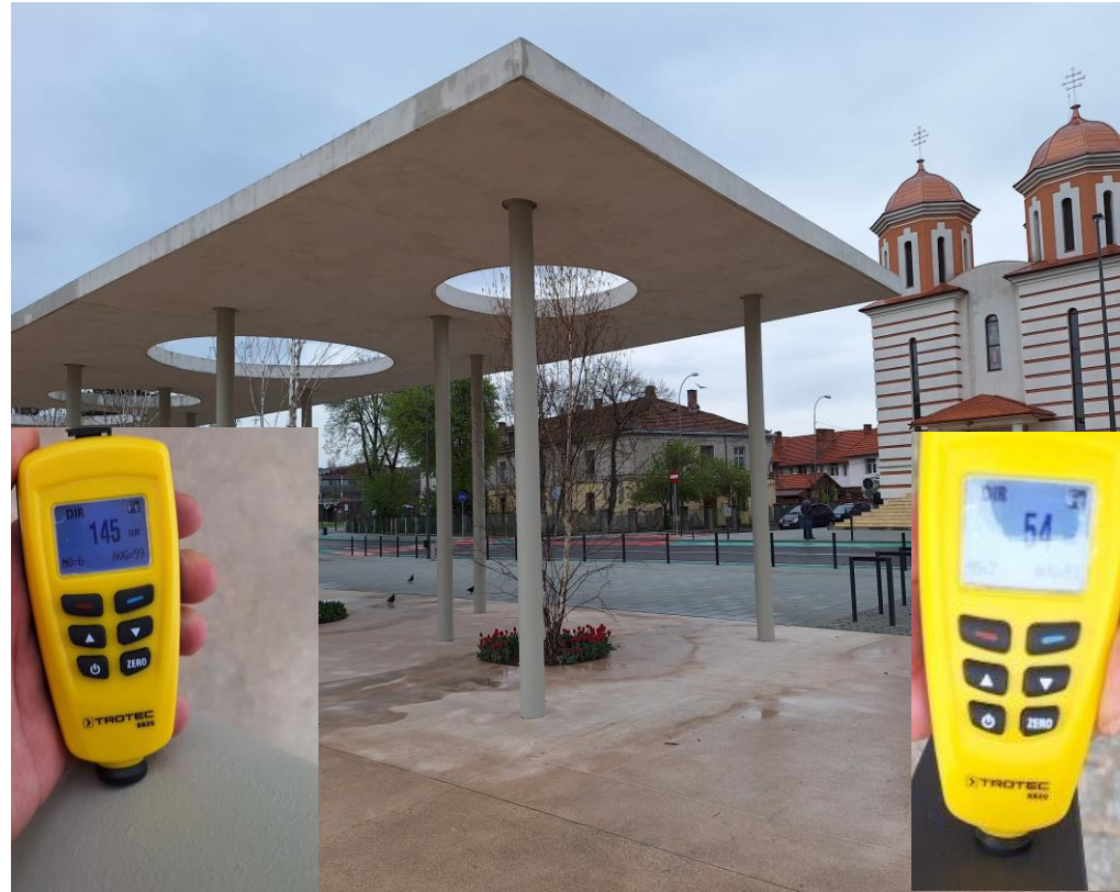
145 de microni de vopsea stâlp de susținere acoperiș
