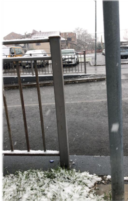
Stâlp de iluminat zincat termic (dreapta imaginii) și gard corodat (stânga imaginii)
