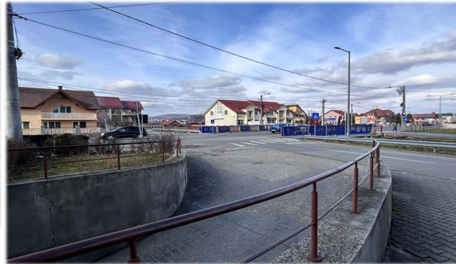
Balustradă 35 micrometri vopsea.
