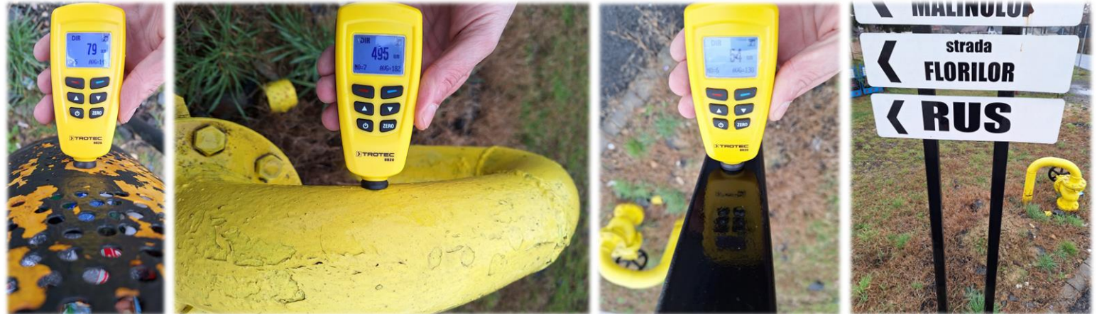
Măsurători luate la elemente metalice acoperite anticoroziv prin vopsire
