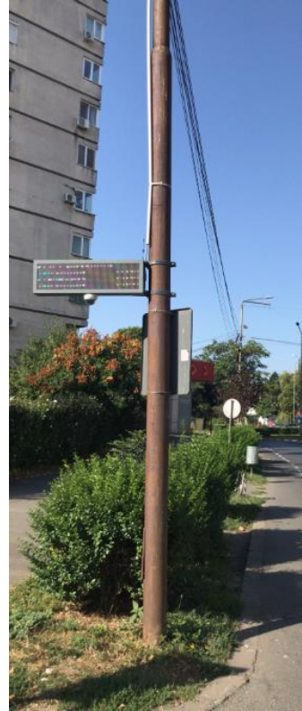
Stâlpi corodați. Exemplu de grosime de strat de coroziune de 36 de microni
