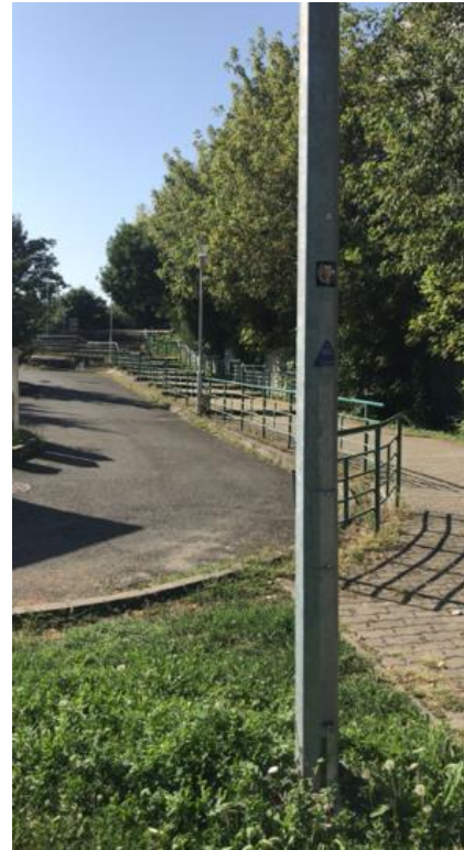
Balustradă protejată prin vopsire și stâlp zincate termic
