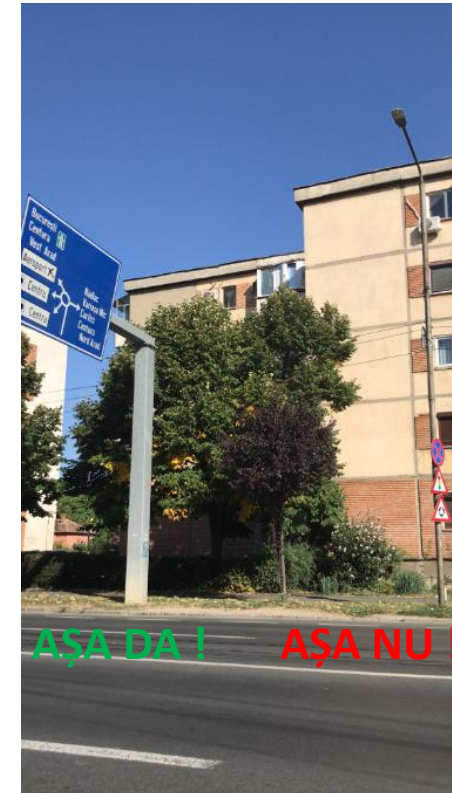
Aspect comparativ confecție indicator zincat termic și stâlp de iluminat corodat
