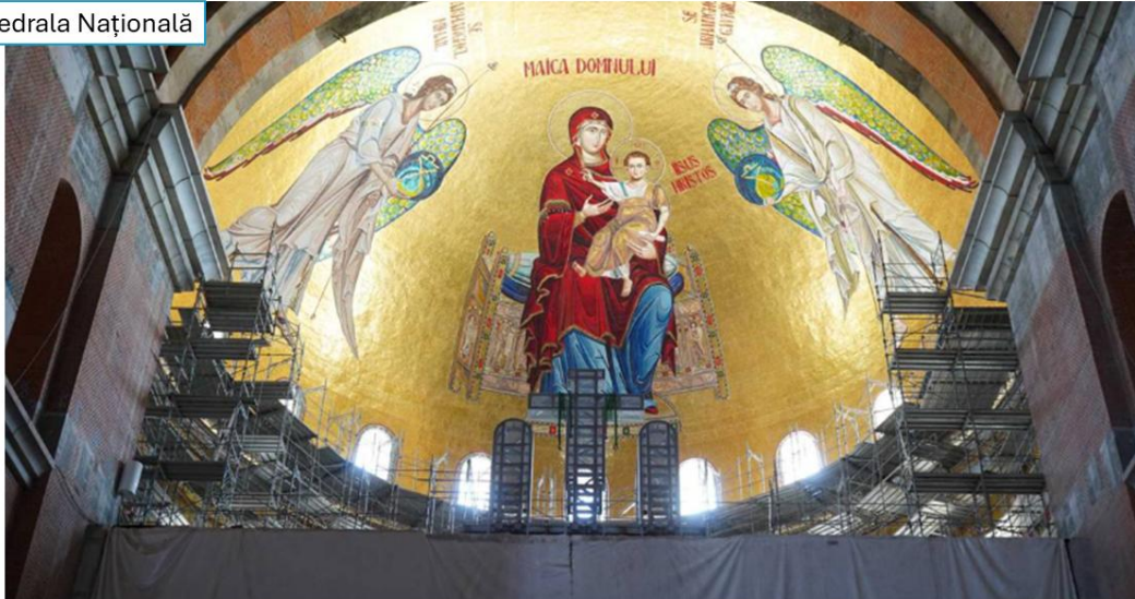
Structurile metalice montate pe peretele Catapetesmei la cota +18,00m – Sursa Basilica.ro
