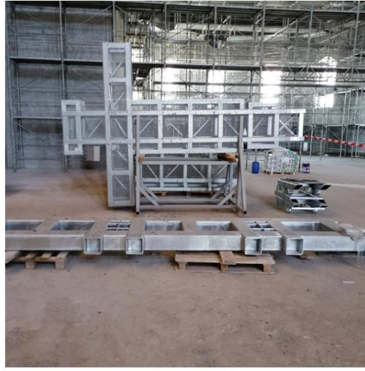
Structurile metalice depozitate pe planșeul de la cota +/-0,00
