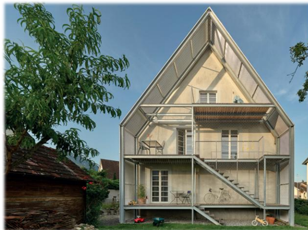
De la structură de rezistență, la culoare
