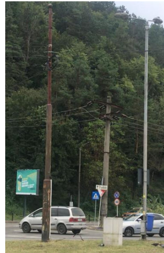
Stâlp acoperit de coroziune (stânga imaginii) alături unui stâlp protejat anticoroziv prin zincare termică (dreapta imaginii)
