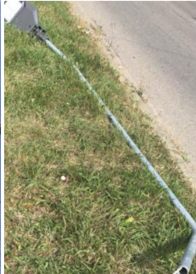
Console corpuri de iluminat se înlocuiesc cu unele zincate termic
