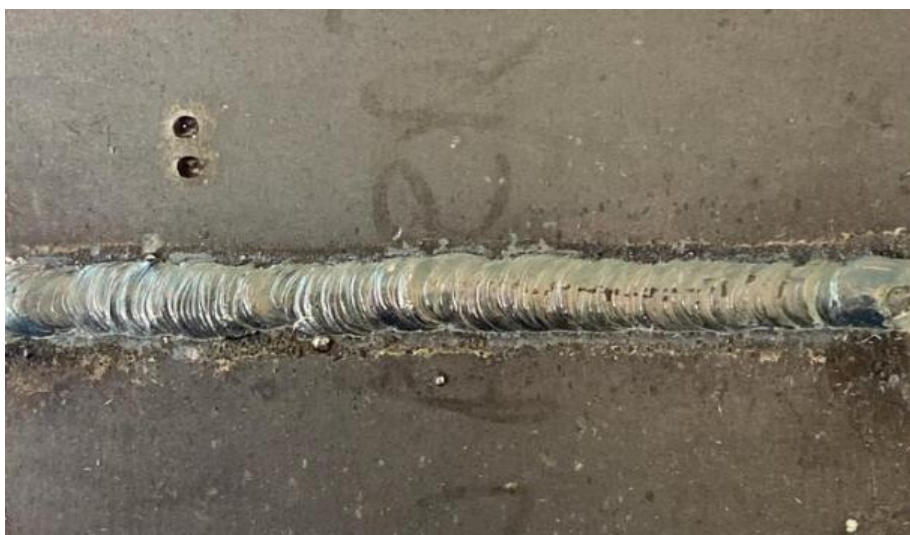
Fig. 20 Cusătura înainte de zincarea termică
