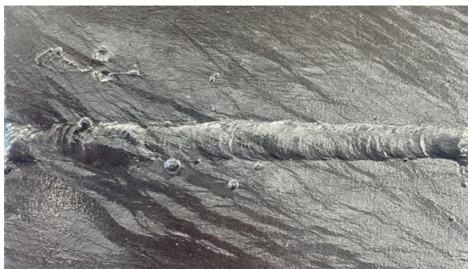
Fig. 21 Cusătura după zincare termică
