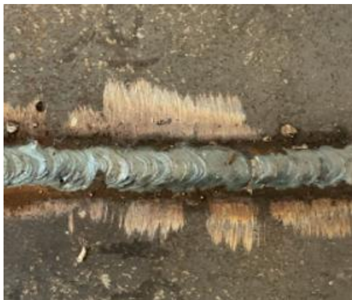
Fig. 8 Cusătura înainte de zincarea termică
