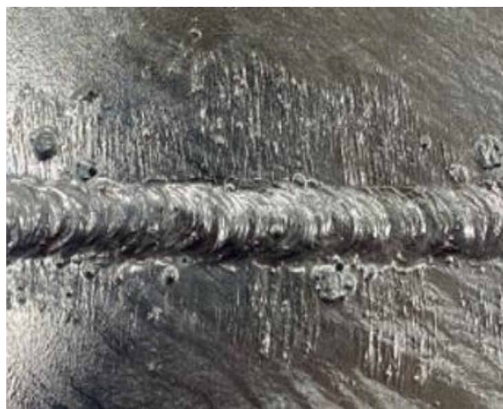
Fig. 9 Cusătura după zincare termică
