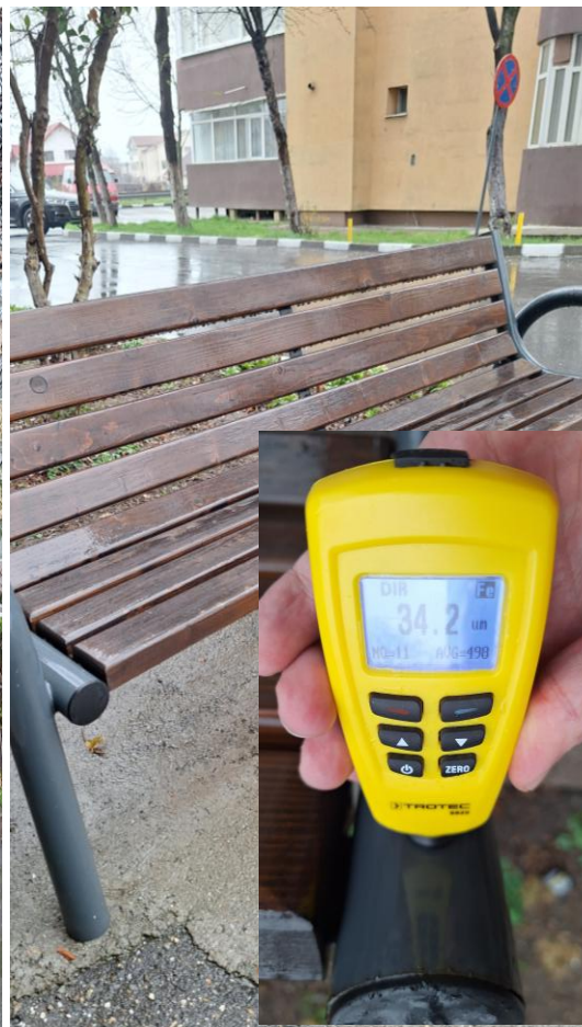
Bancă 34 de microni vopsea care va necesita intervenții de mentenanță în următorii ani. Se observă urmele de coroziune.
