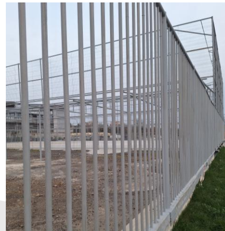
Gard împrejmuire acoperit anticoroziv prin zincare 32 microni zincare.
