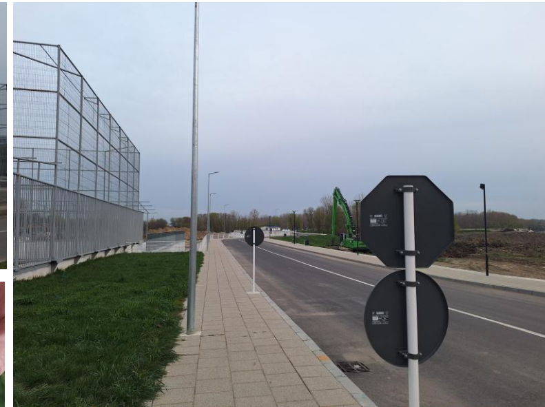
Semn de circulație protejat anticoroziv prin vopsire cu un strat de 81 de microni de vopsea. Pentru mediul de corozivitate C3 (urban/industrial) pentru suprafețe protejate anticoroziv prin vopsire se recomandă consultarea standard SR EN ISO 12944:2018
