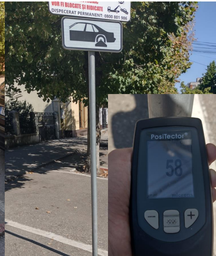
Pentru mediul de corozivitate C3 (urban/industrial) grosimea stratului de 58 microni de zinc asigură protecție anticorozivă pentru minim 34 de ani fără întreținere
