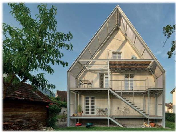
De la structură de rezistență, la culoare
